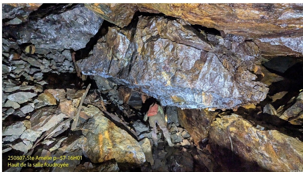
Figure 69 SAINTE AMELIE : zone d'effondrement avec des blocs
